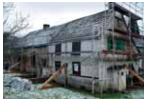
Sanierung der Arbeiterhäuser. Foto: Klaus Kaiser, HVE.
